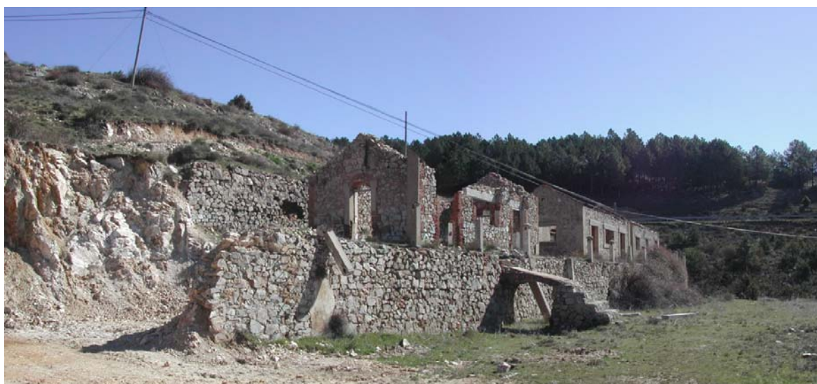
Figura 12: Junto a las canteras de mármol quedan las ruinas de los edificios utilizados durante su explotación.
